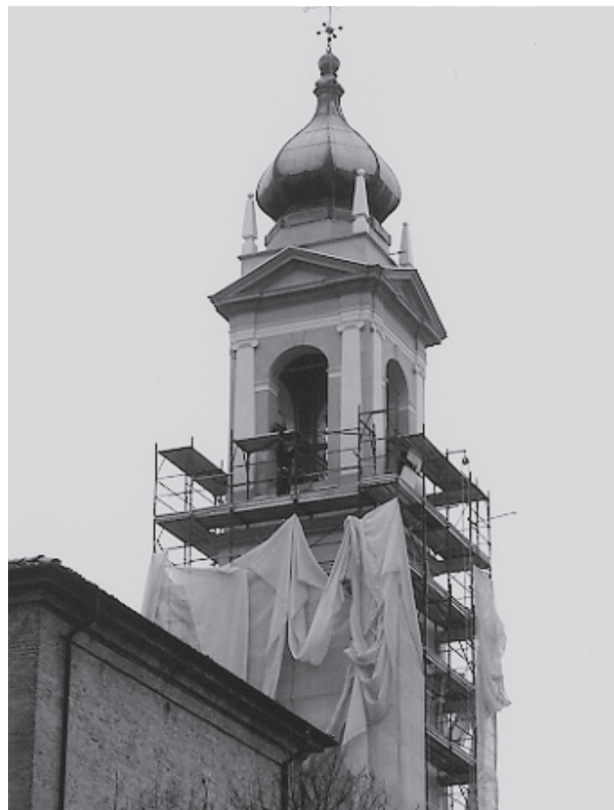
Ponteggi durante il restauro del campanile di Moscazzano nello scorso anno
