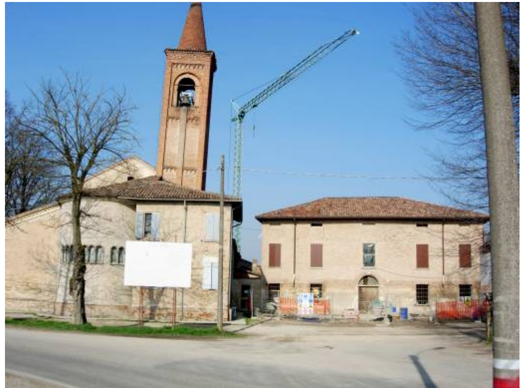
Il complesso parrocchiale di Mortizzuolo durante gli attuali lavori di restauro.
